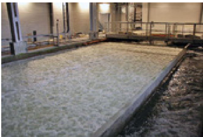
Figur 6.2: CO 2 utlufting ved Marine Harvest Nordheim.
