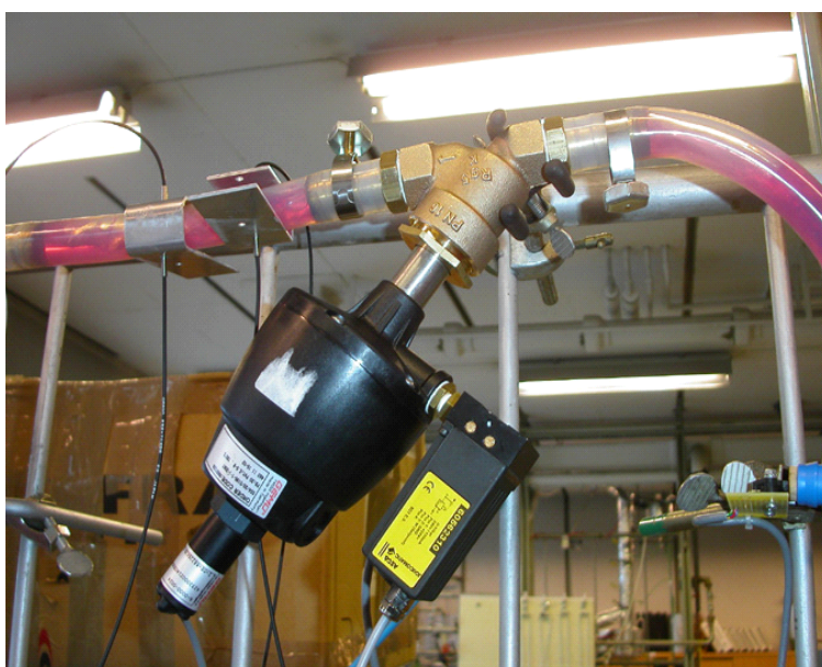
Figur 3.7: Reguleringsventil oppstrøms separator
