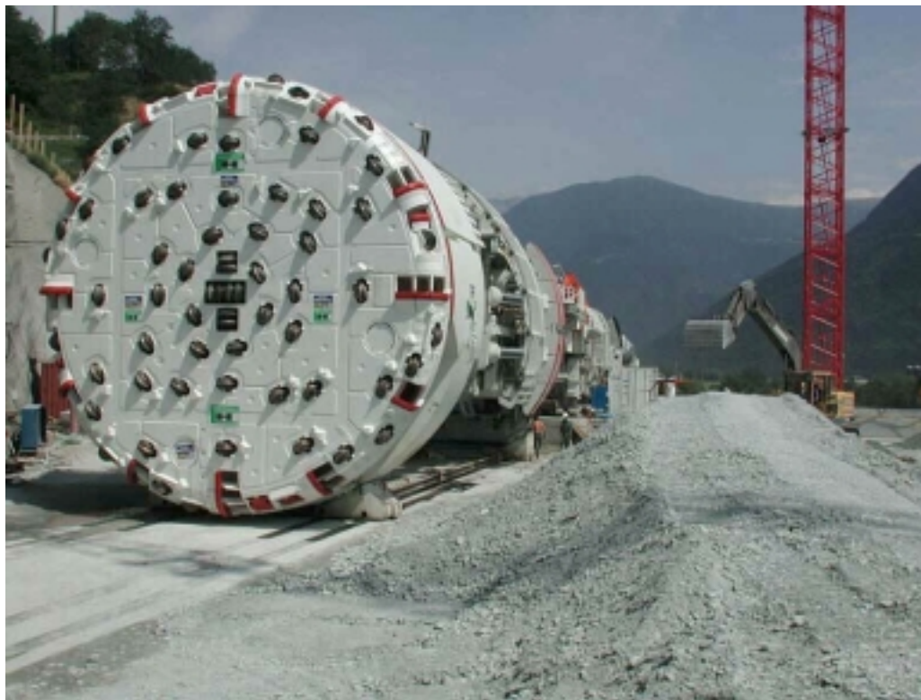
Figur 3.12 Tunnelboremaskin fra Raron i Sveits. Diameter 9,6 m.
