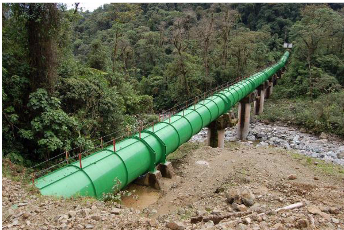
Bildet viser en rørgate til kraftverket Rio Macho i Costa Rica. (Foto: N. Olsen)
