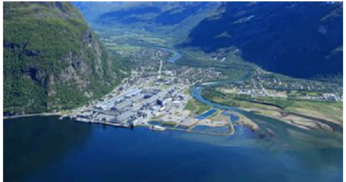
Hydro Aluminium, Sunndalsøra | Mannvit mannvit.no
